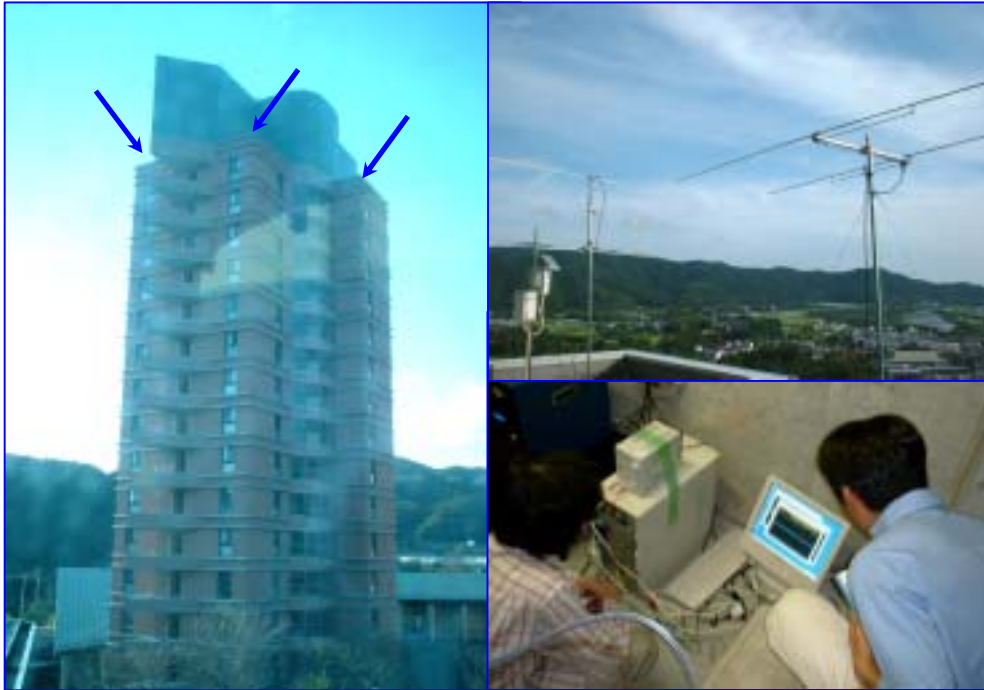
図1 高知工科大学ドミトリーに設置された6ch HRO観測機器。ドミトリー屋上4隅にあるスペースのうち3箇所(左写真の矢印 ~ )を利用し、アンテナを2機ずつ配置した。右上写真は に設置された天頂南北面(左)と水平南方向(右)の受信アンテナ。右下は屋上の管理室内に設置された観測用PC。
